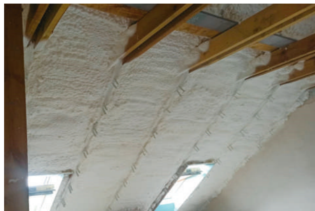
Poddasze z zaaplikowaną pianką ULTRAPUR
