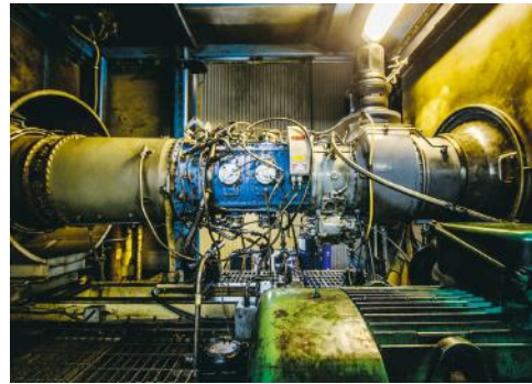
Turbina gazowa – początek budowy lokalnego systemu energetycznego, 2000 r.
