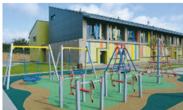
Otwarty w 2019 r. w Strzegomiu nowoczesny budynek przedszkola i żłobka o podwyższonych parametrach energetycznych
