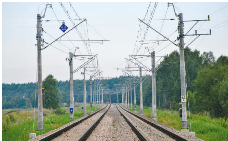
Sieć trakcji kolejowej na słupach ETG
