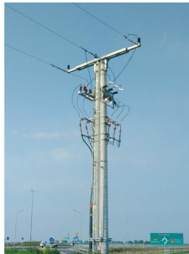
Stanowisko słupowe średniego napięcia
