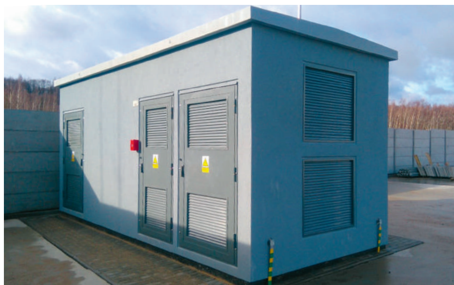
Stacja transformatorowa w obudowie żelbetowej
