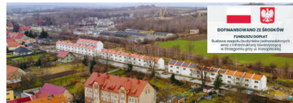
Nowy kompleks mieszkań komunalnych w Strzegomiu w trakcie realizacji
